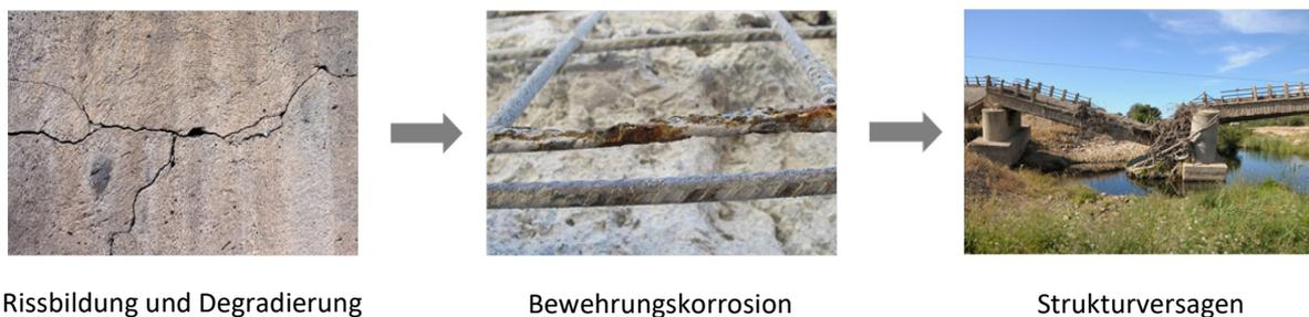
Abbildung 1-1: Degradationsprozess von Betontragwerken.
