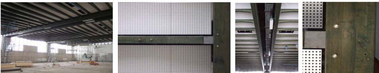
Abbildung 7: Turnhalle in Murnau, Landkreis Garmisch-Partenkirchen: Hauptträger Pos. H3 - Auflagerdetail
