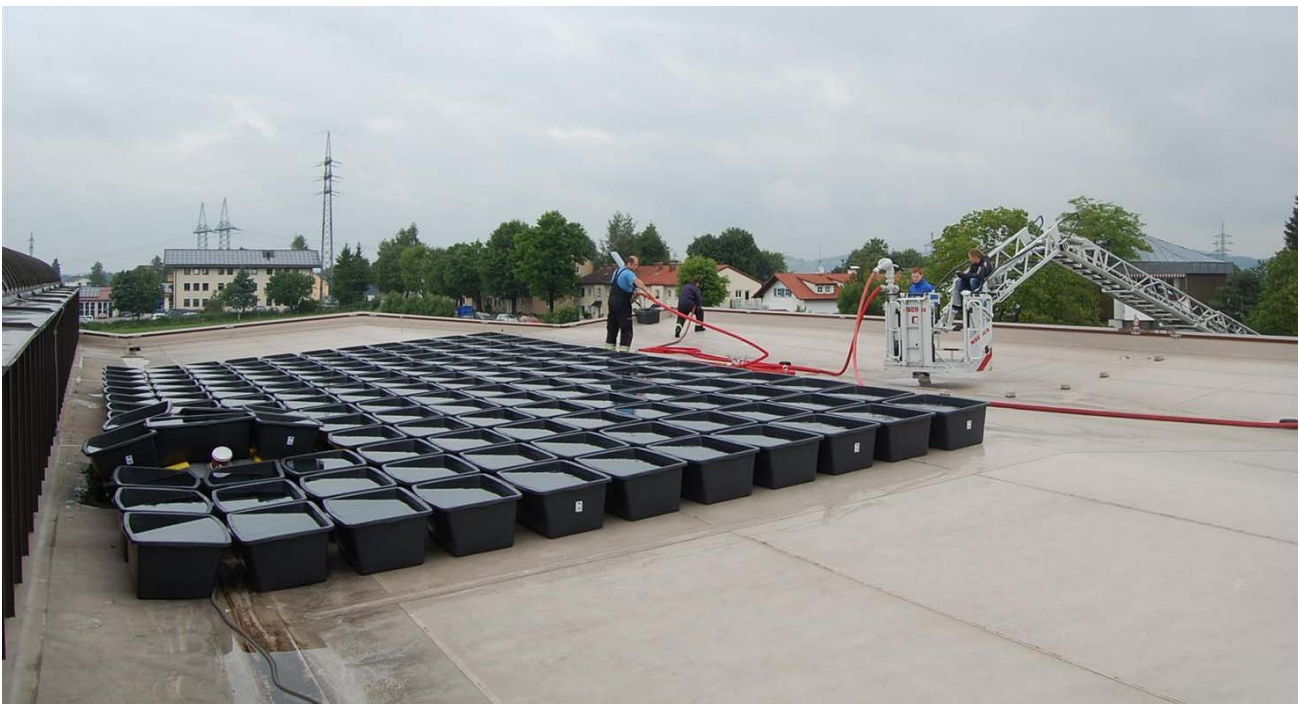
Abbildung 45: Künstliche Last auf dem Dach der Turnhalle, bestehend aus 154 wassergefüllten 90l-Mörtelkästen, unmittelbar nach Abschluss des Befüllvorgangs
