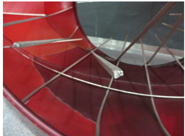
Abb. 18: Detail trapezförmiger Zuschnitt des Plasma geschnittenen Edelstahls (Foto: JS, 10.2017)
