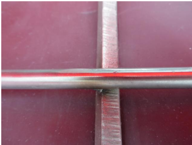
Abb. 17: Detail Schweißpunkt industrieller Rundstahl und Plasma geschnittene Stahlstäbe mit gelblicher Verfärbung durch Schweißprozess (Foto: JS, 06.2017)
