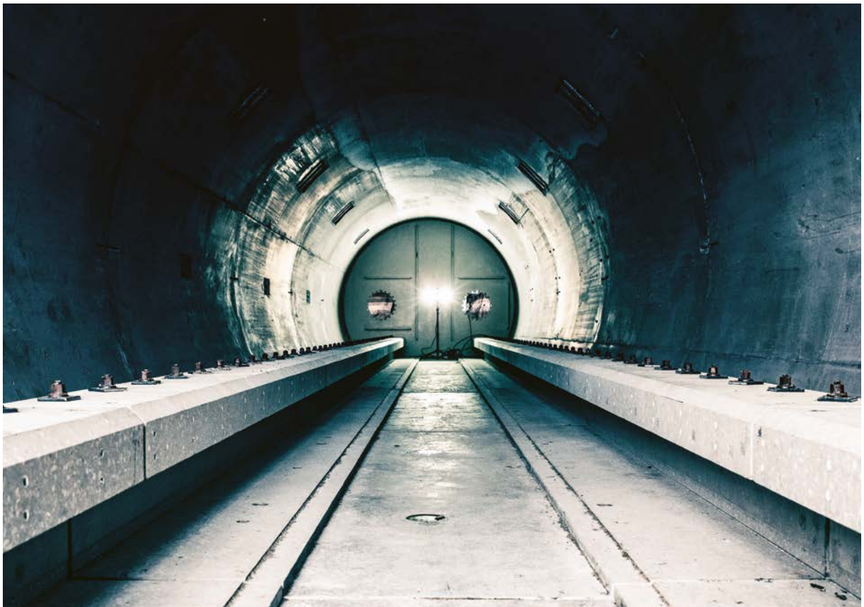
Die neue Hyperloop-Teststrecke in Ottobrunn / Taufkirchen ist 24 Meter lang und aus ultrahochfestem Beton. BILD TUM Hyperloop
