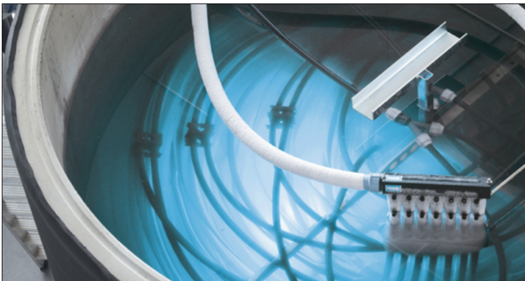
Abb.27: In Wasser eingelassenes Wärmeübertragerrohr des Viessmann VITASET Eis-Energiespeicher [38]
