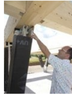
Abbildung 9: Stützenanschluss Träger © Wulf Architekten
