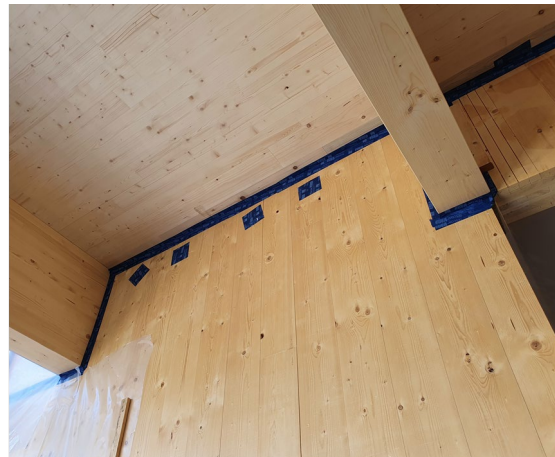
Abbildung 25: Großflächige Wand- und Deckenelemente aus Brettsperrholzelementen. © Wulf Architekten
