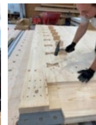
Abbildung 12: Steckverbindung Brettsperrholz © Pirmin Jung Schweiz AG
