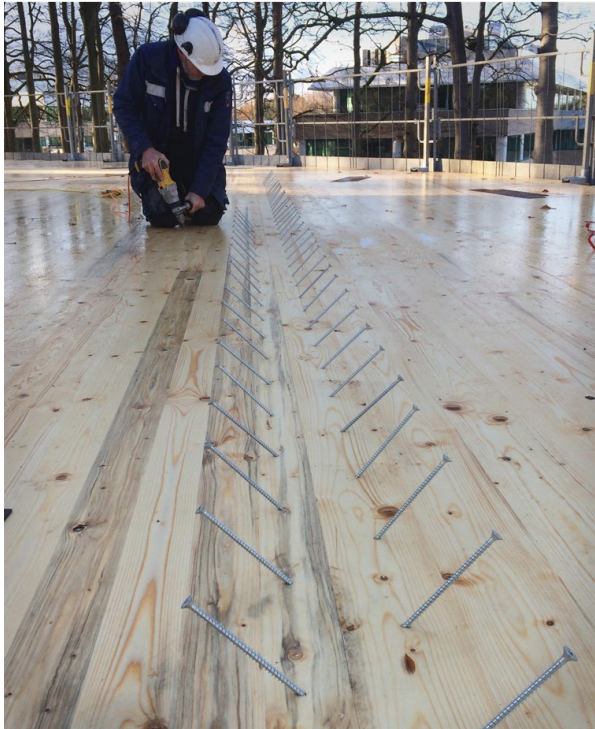
Abbildung 22: kraftschlüssige Verbindung durch Verschraubung, © Rau Architekten
