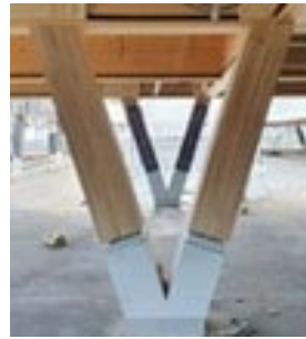
Abbildung 8: Stützenansicht Parkdeck © Wulf Architekten
