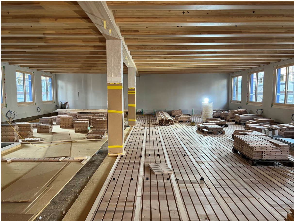
Abbildung 28: Verlegung des Buchenunterlagsbodens, © Pirmin Jung Schweiz AG, Fotografin Clementine Hegner-van Rooden
