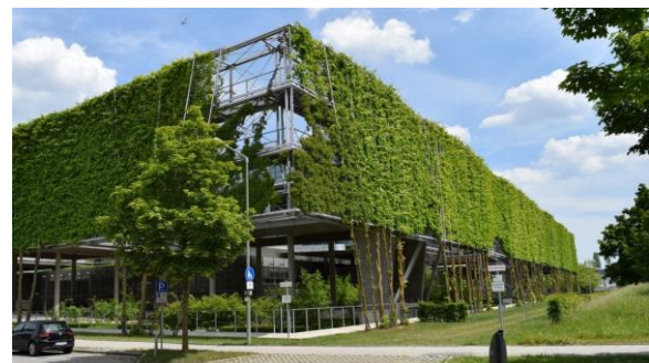
Abbildung 1: Bodengebundener Bewuchs an Kletterhilfen (Swiss Re Bürogebäude München); (Quelle: Bundesverband GebäudeGrün)
