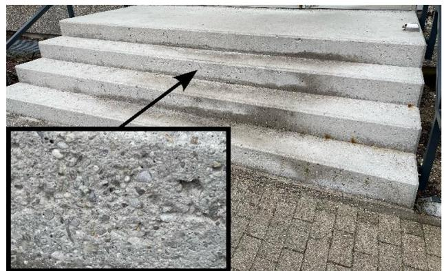
**Abbildung 1** Frost-Tausalz induzierte Oberflächenschädigung an einer Stahlbetontreppe im Außenbereich
