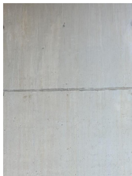
Abbildung 31 Wandfläche im EG des DonauTowers aus CO 2 -effizientem Beton, Eigenes Foto
