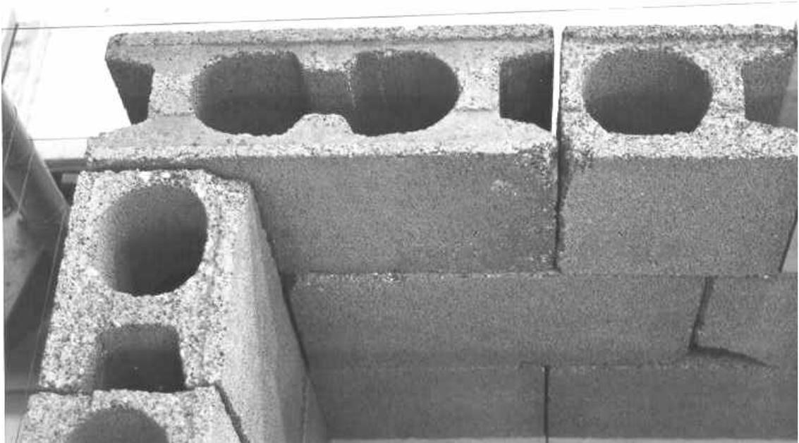
Fig. 1.3.3.3-2: Vertikale Lagefehler durch Nut- Federsystem ohne Unterbrechung
