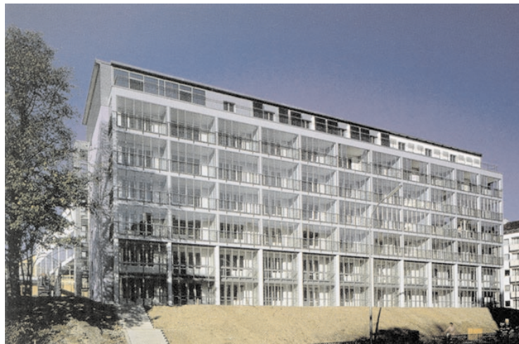
Abbildung 2.24: Luftkollektoraddition: Niedrigenergiehaus Baumgartner-/Ganghoferstraße in München, 1996 (Architekten: Raupach + Schurk); die Luftkollektoren sind im obersten Geschöß mit Hilfe von Aluminium-Winkelprofilen an der Außenwand befestigt; Foto: [46]
