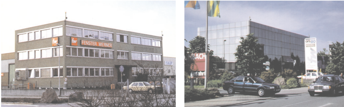
Abbildung 2.2: Sanierung eines Bürohauses [31]: Das ursprüngliche Erscheinungsbild kann durch eine Glasvorhangfassade positiv verändert werden.
