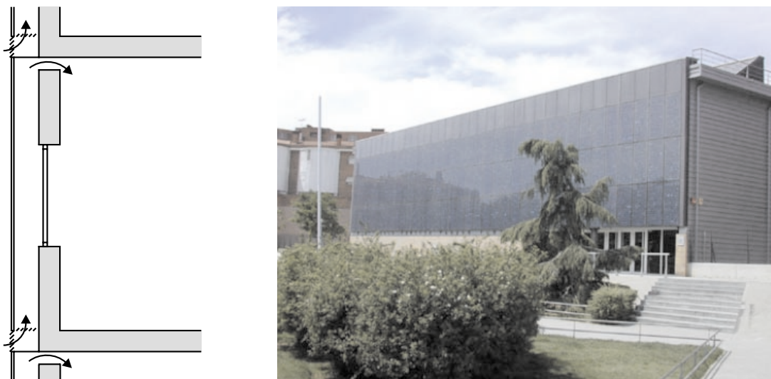
Abbildung 2.31: Bibliothek Pompeu Fabra in Mataro bei Barcelona (Architekt: Miquel Brullet, 1998): Fassadenintegrierte, hybride Photovoltaikanlage; Foto: [112]
