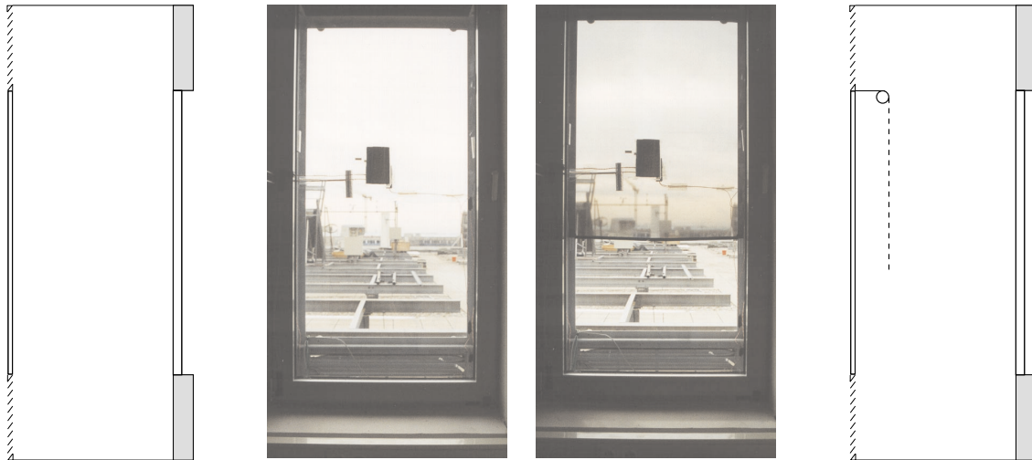
Abbildung 5.15: Innenansicht eines Fensterkastens ohne (links) und mit (rechts) einzelner, hier nur teilweise abgesenkter Matrix
