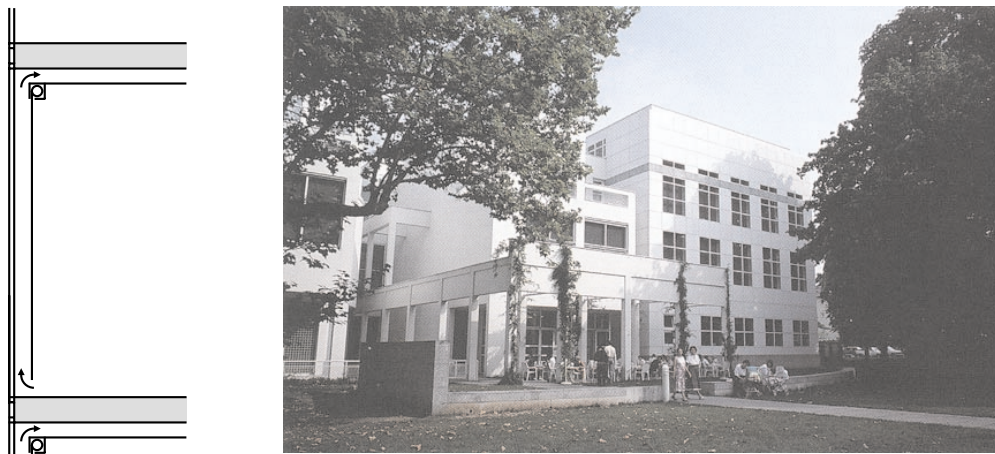
Abbildung 2.9: Museum für Kunsthandwerk in Frankfurt am Main, 1984 (Architekt: Richard Meier): Abluftfassade mit steigender Luftführung; Foto: [16]
