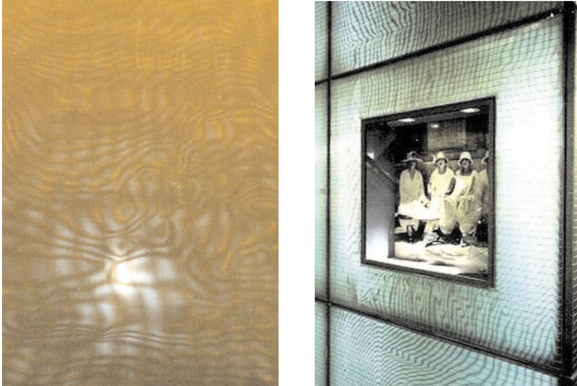
Abbildung 3.19: Links: Interferenzerscheinungen an unbehandelten Kupfergeweben; rechts: Moiré-Effekt an Drahtgeweben hinter einer Verglasung (Bally Shop Bahnhofstraße, Zürich [111])
