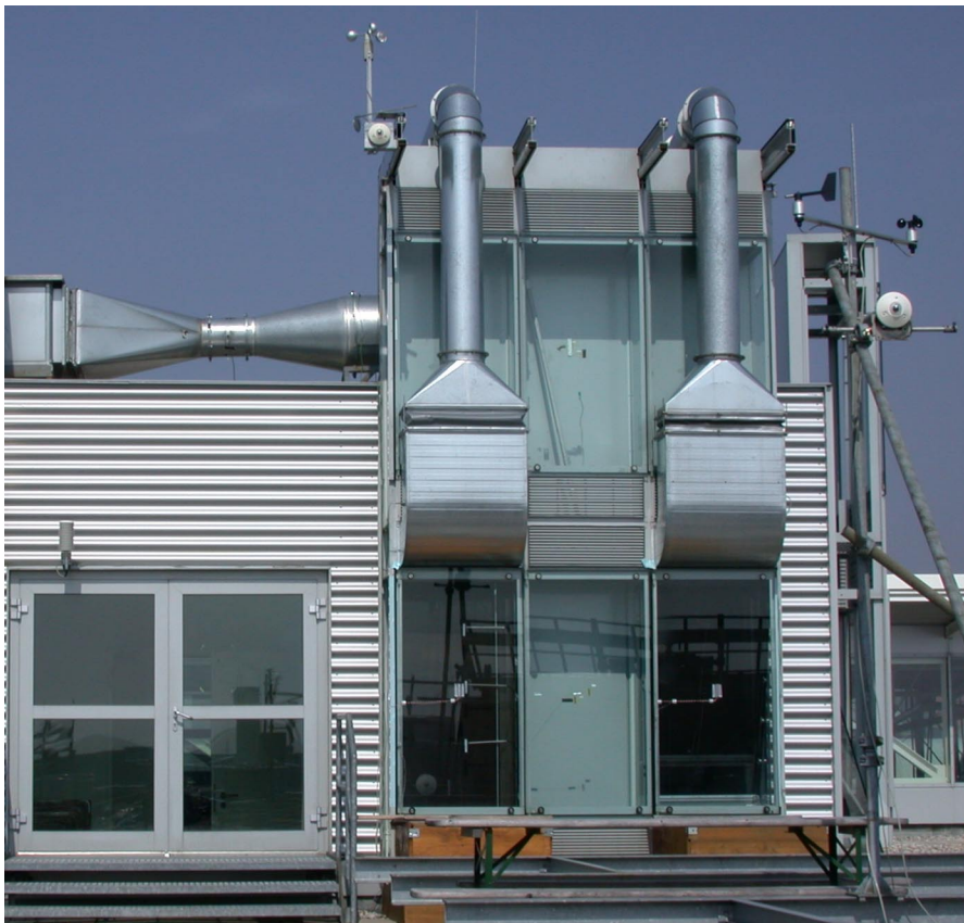
Abbildung 4.1: Ansicht des südorientierten doppelschaligen Versuchsstands mit den beiden Fensterkästen FK1 (links) und FK2 (rechts) samt integrierten verstellbaren Matrixkollektoren und Luftabsaugkanälen, sowie dem dazwischen liegenden Schachtbereich
