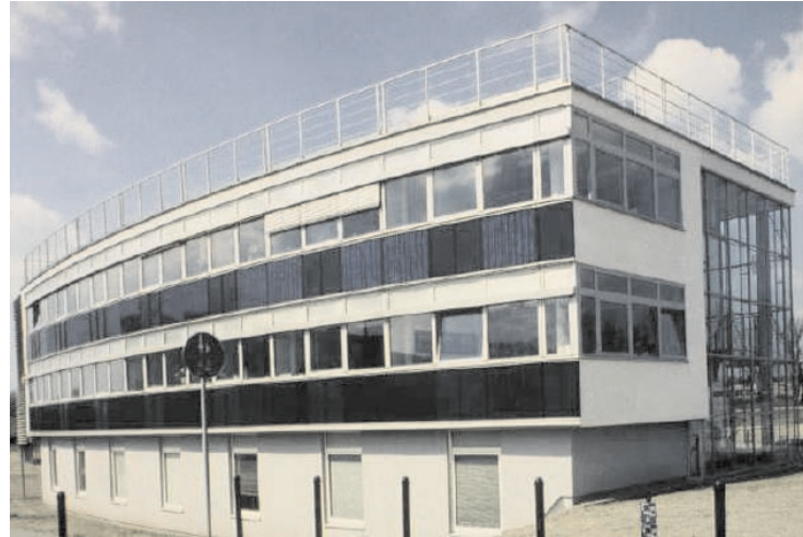
Abbildung 2.29: Institutsgebäude in Frankfurt an der Oder (Architekten: Schürmann/Spaenell): SOLARWALL-Kollektorpaneele in Kombination mit dahinterliegenden brüstungsintegrierten Lüftungsgeräten; Foto: [114]
