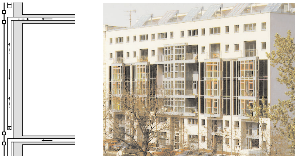
Abbildung 2.25: Integration von Luftkollektoren in die Außenwand beim Mehrfamilienhaus Lützowstraße in Berlin, 1988 (Architekten: IBUS Institut für Bau-, Umwelt- und Solarforschung ); Foto: [112]
