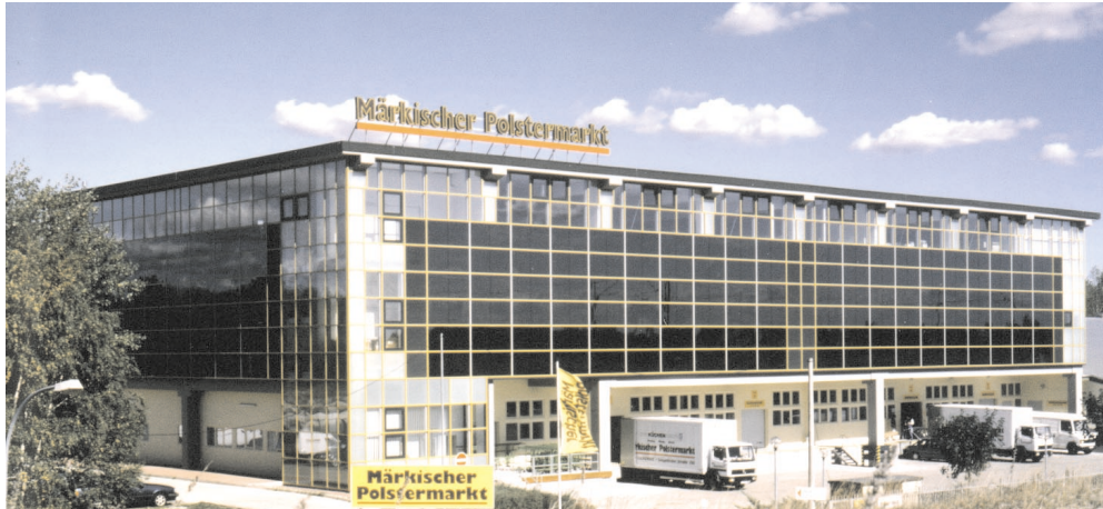
Abbildung 2.20: Märkischer Polstermarkt in Falkensee, 1997 (Architekturbüro Raché): Integration von Luftkollektoren in eine Pfosten-Riegel-Konstruktion; Foto: [112]
