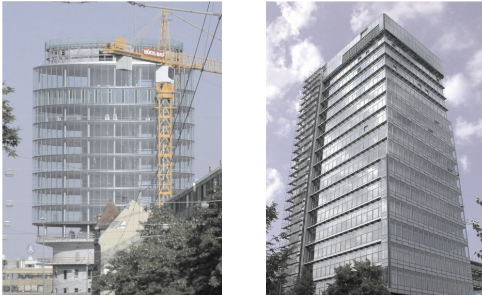
Abbildung 1.1: In München im Bau befindliche Gebäude mit Doppelfassade. Links: Westansicht (31.05.2002) der Mercedes-Benz Niederlassung am Mittleren Ring (LAI Lanz Architekten + Ingenieure); rechts: Südostansicht (05.07.02) des Fraunhofer-Hauses an der Hansastrasse (HENN Architekten Ingenieure)
