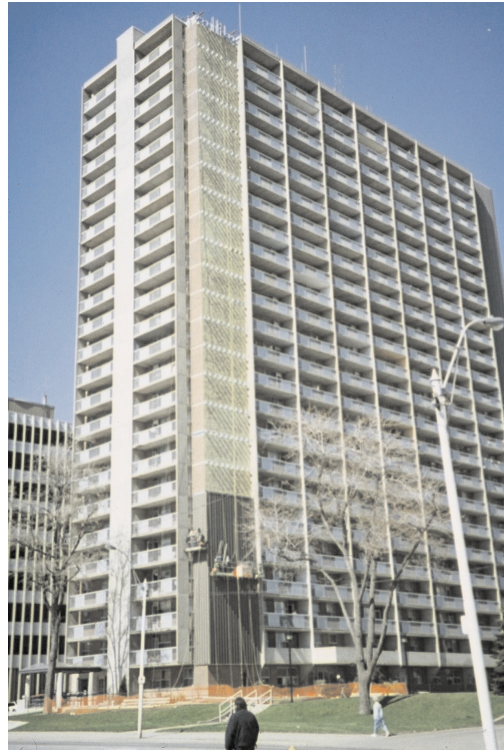
Abbildung 2.28: Unverglaste Luftkollektorfassade SOLARWALL an einem Wohngebäude (Ouellete Manor Senior Citizens' Building) in Windsor/Ontario, Kanada, 1994 (Conserval Engineering Inc.); Foto: [114]
