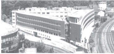
schrägluftbild multifunktionsgebäude brugg
