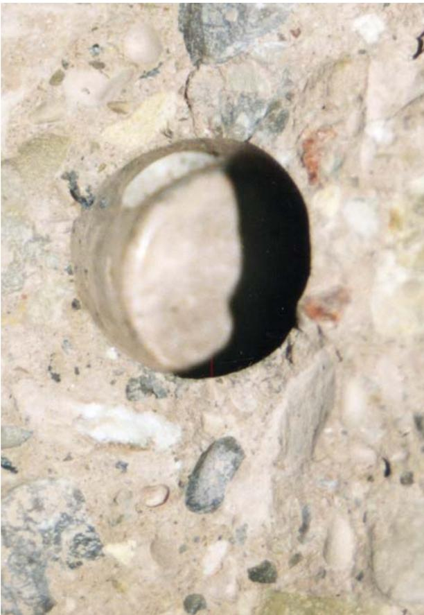
Dübelloch 2 mit Bohrloch an der Oberseite und nicht abgeplatzttem Steg zwischen Bohrloch und Fuge
