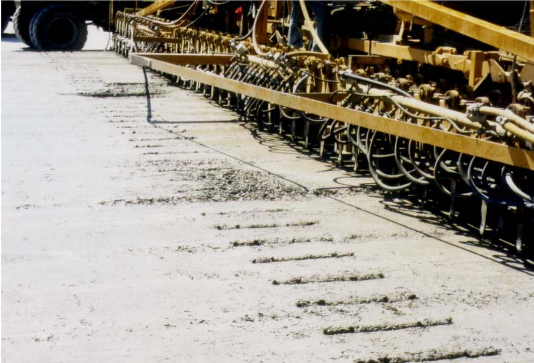
Abb.1.1: Maschinelles Einrütteln der Dübel in den Unterbeton
