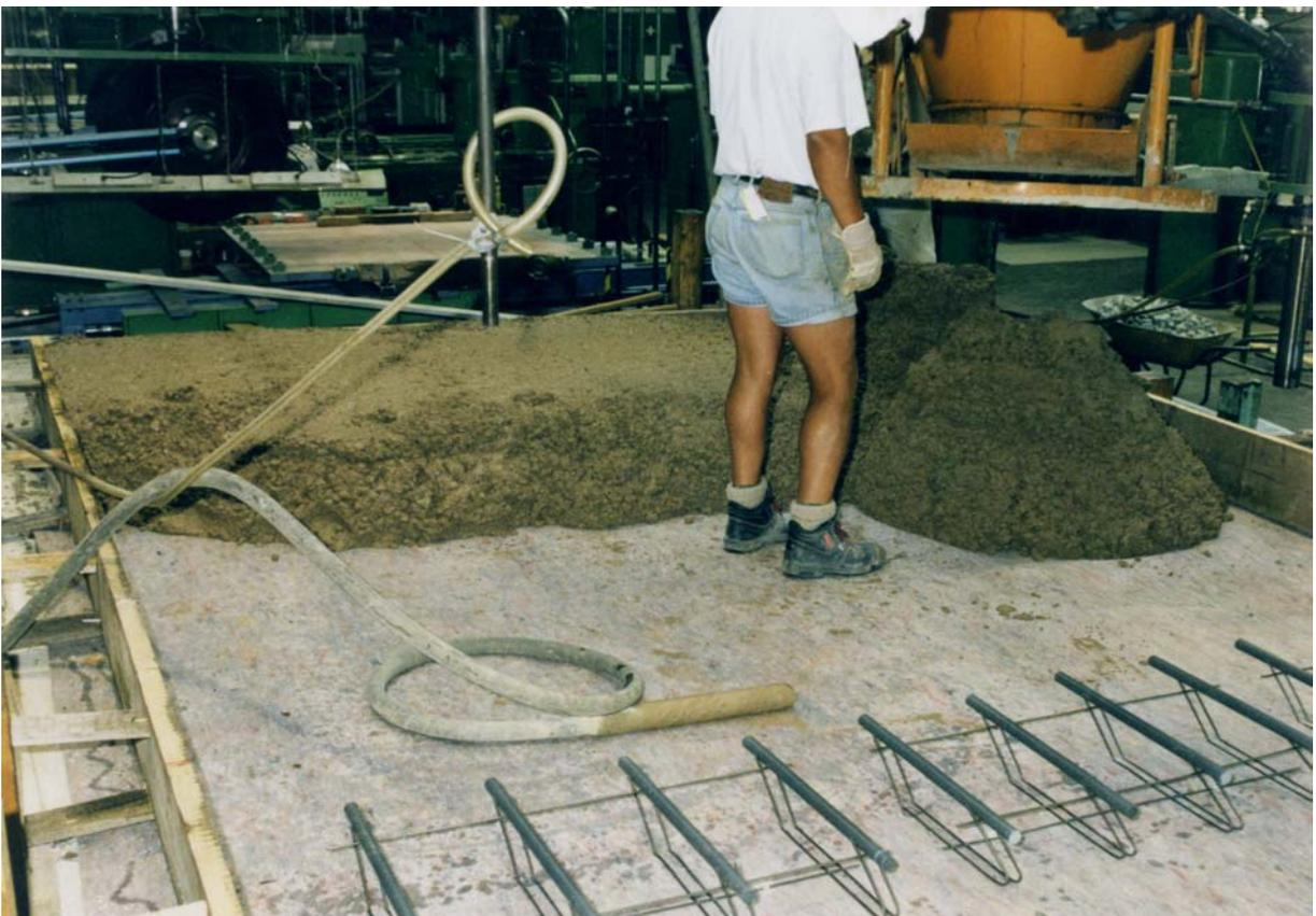
Einbringen des Betons mit Betonkübel und Verdichten mit Innenrüttler
