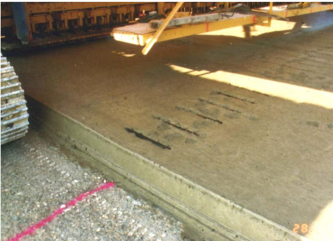
Abb. 1.2: Markierung der Dübellage in Längsrichtung für das spätere Fugenschneiden
