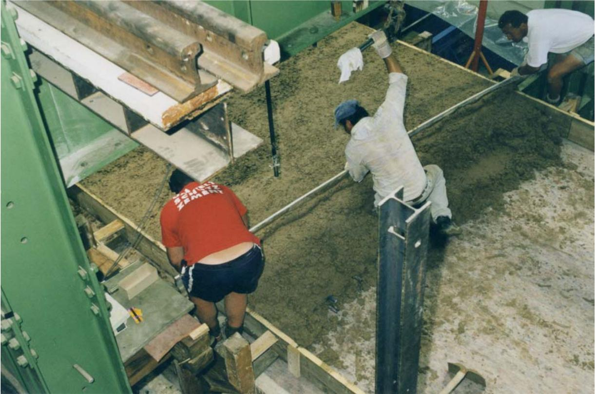
Abziehen des frischen Betons mit einer Bohle
