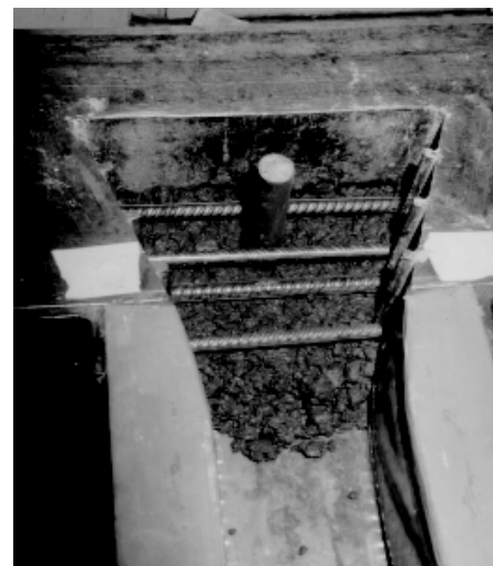
Bild 3-2: Schichtweiser Einbau der Bewehrungslagen in das Querhaupt des Reißrahmens
