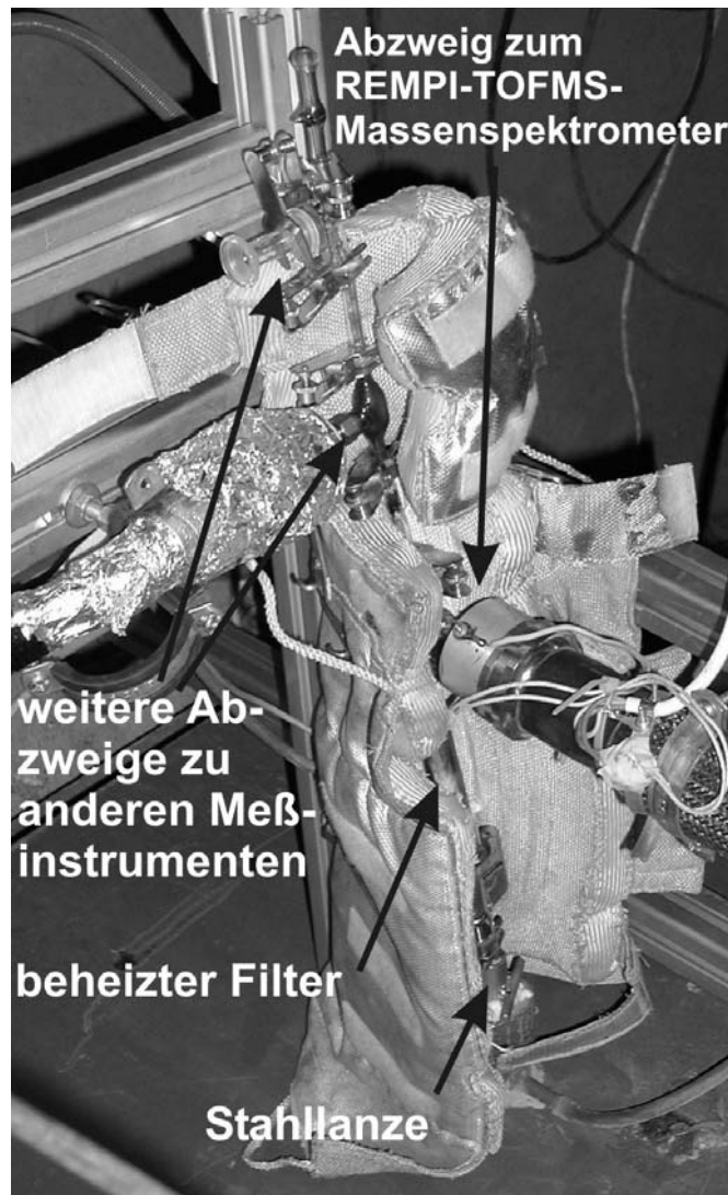
Abbildung 74: Foto der Probenahme auf dem Deckel des Feuerraumes der Hackschnitzelheizung (Meßplatz 2), Kloostergut Scheyern
