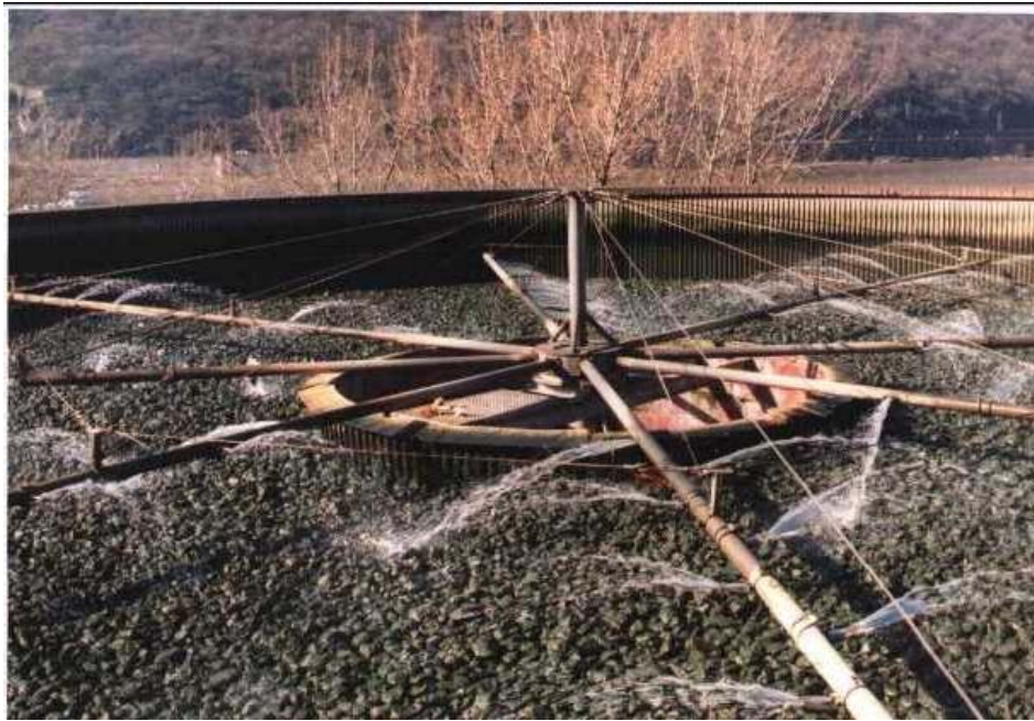
Abbildung 1.1: Tropfkörper-Berieselungsanlage der Kläranlage Oberwesel als Beispiel für den Praxisbetrieb eines aeroben Festbettverfahrens zum Ammoniumabbau (aus [98])
