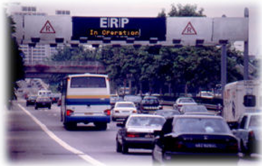
Abbildung 3.4: Einsatz von DSRC zur automatisierten Erhebung von Straßengebühren.
