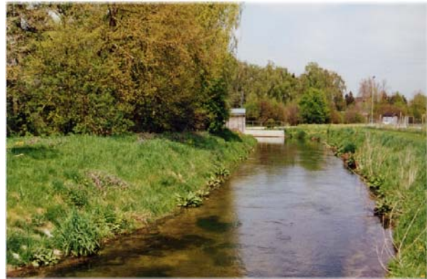
Abb. 30: Kraftwerk bei Fkm 0,0
