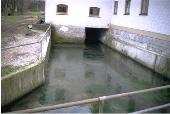
Abb. 29: Kraftwerk bei Fkm 0,4
