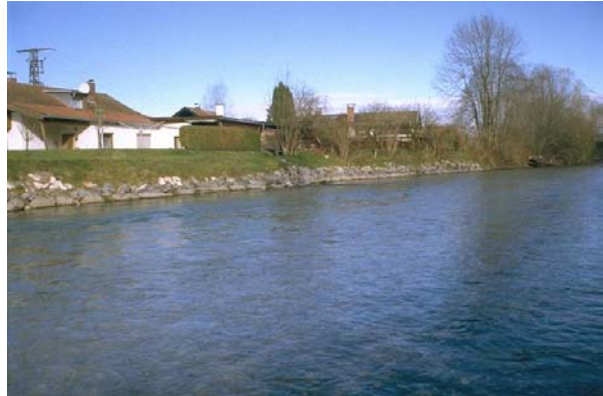
Abb. 18: Loisachufer mit Blocksteinverbau
