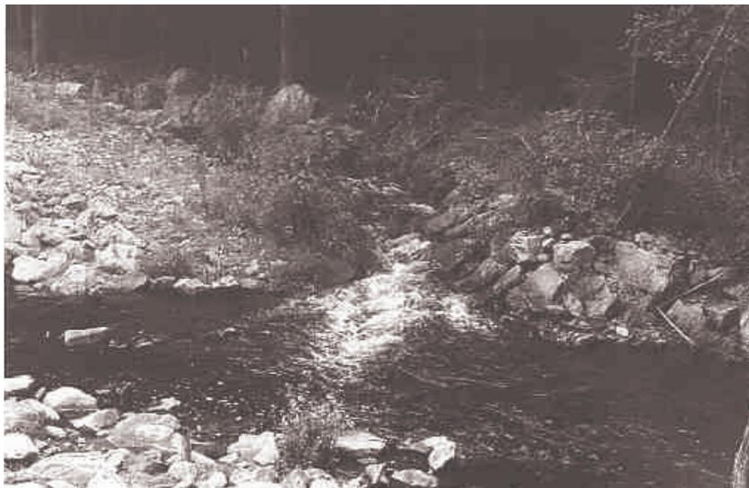
**Abb. 24: Wanderhilfe Linden, zu steil errichteter Abschnitt, Saußbach**
