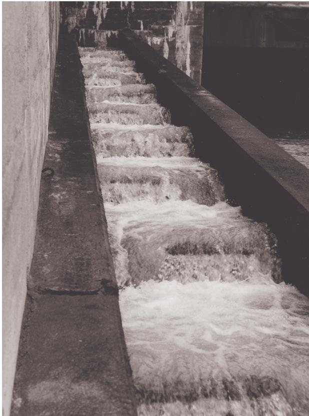
**Abb. 2: Beckenpaß mit Kronenausschnitt, Kraftwerk Kachlet, Donau**
