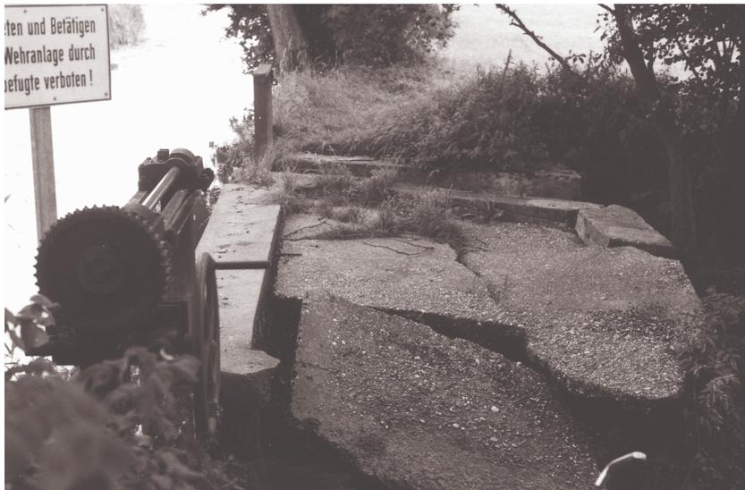
**Abb. 46: Baufälliges Ausleitungswehr, Kleine Laber**
