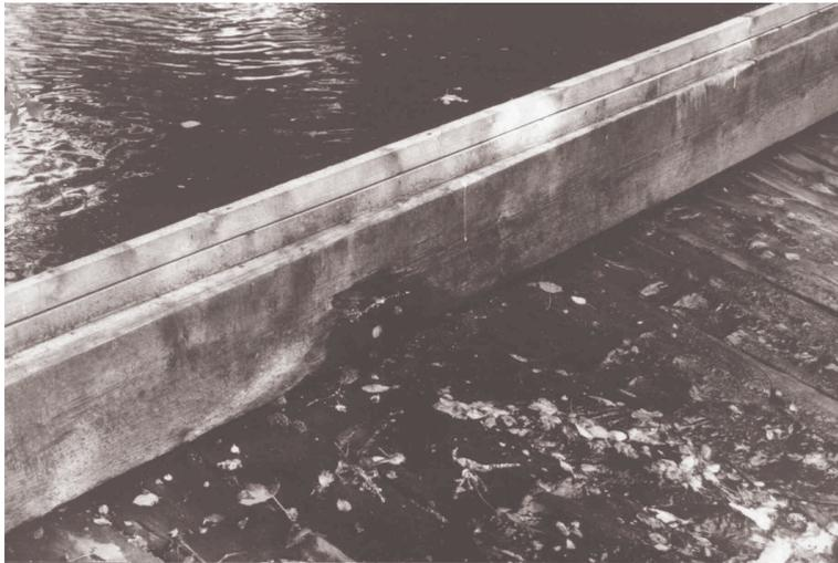
**Abb. 76: Bei NQ knapp über Staupiegel liegende Restwasseröffnung, Reschbach, Abfluß  $\ll 1$  l/s**
