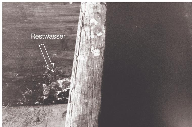
**Abb. 75: Vorsätzlich mit einem Stein eine 0,2 m über dem Grund liegende Restwasseröffnung verschlossen, Reschbach, Abfluß  $\ll$  1 l/s**
