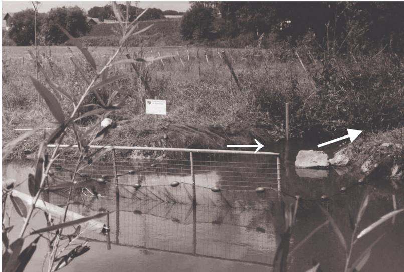
**Abb. 22:** Ausleitung der Wanderhilfe Eitting (Pfeil), abgesperrt durch Fangreuse mit Stahlrahmen und Schwimmbalken zur Vermeidung von Treibgutlagerungen und Anheben des Netzflügels, Kleine Laber
