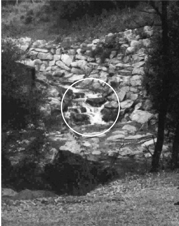
**Abb. 54: Im unteren Bereich (Kreis) zu steil erbaute Wanderhilfe, Saußbach**
