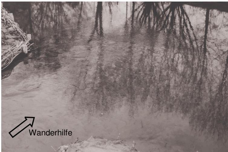
**Abb. 55: Zu geringe Lockströmung ( $v \leq 0,1$  m/s) an der Mündung einer Wanderhilfe, Große Vils**
