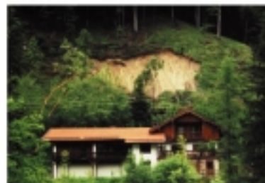
Rutschung Pfingsten 1999. Um den Hang zu stabilisieren, wird das Wasser mit Rohren abgeleitet.
