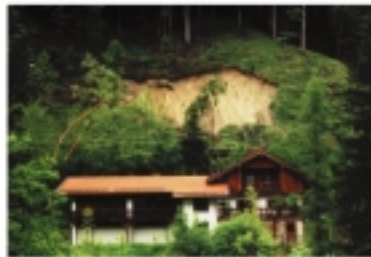
Rutschung Pfingsten 1999. Um den Hang zu stabilisieren, wird das Wasser mit Röhren abgeleitet
