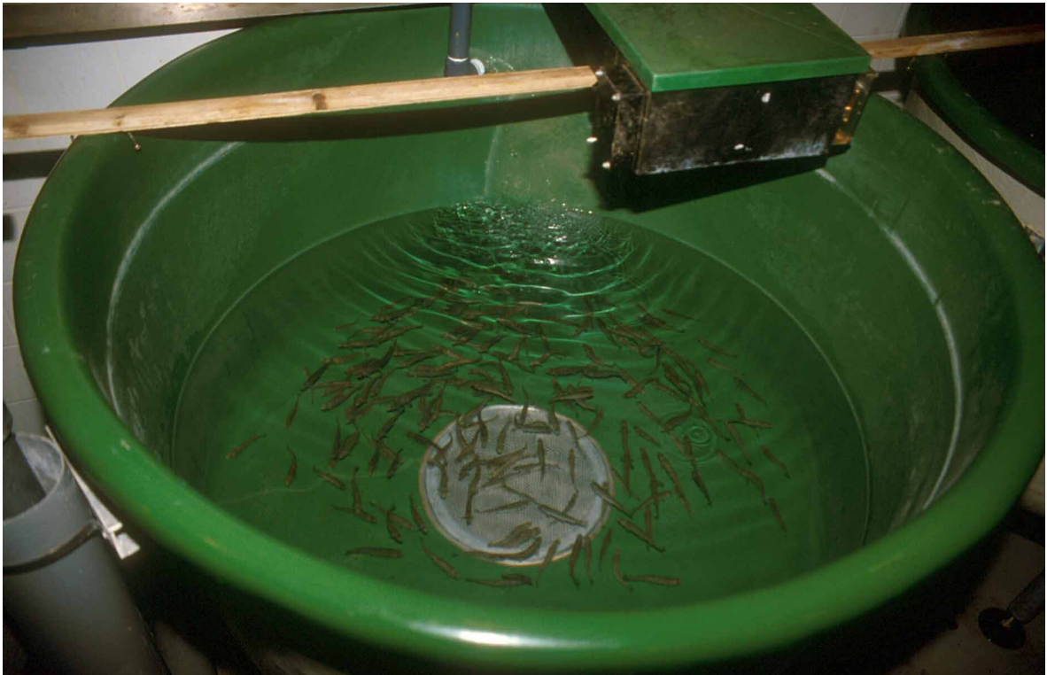
Abbildung 10: Rundstrombecken im Bruthaus (tangentialer Wasserzulauf, zentrales Bodenablaufgitter und Standrohr) mit Bandfutterautomat
