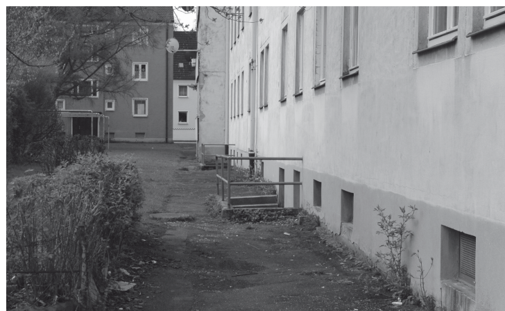
Abb. 4.3.17: Erdgeschoss- zone ohne Bezug zum Außenraum, Zugangstrep- pe zum Keller, Altbestand (Weiden)
