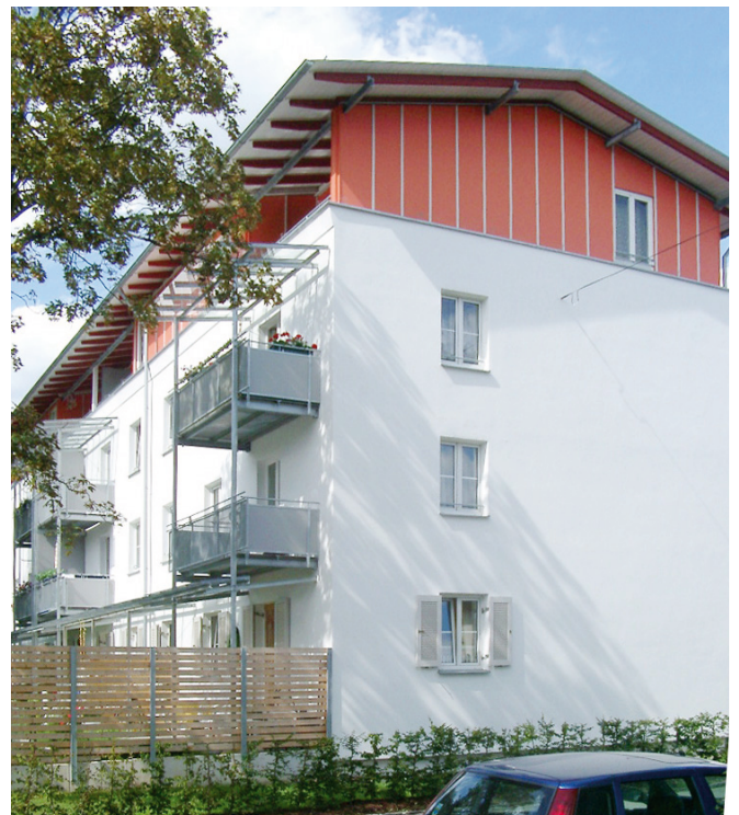
Abb. 4.6.2: Straßenseite eines aufgestockten Gebäudes in Ingolstadt in der Brucknerstraße mit Abschirmung durch Sichtschutzwand
