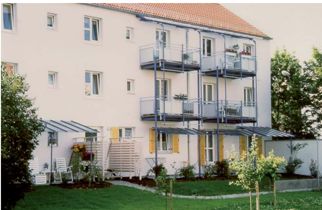
Abb. 4.4.1: Erdgeschoss um ca. 70 cm angehoben mit Bezug zum Außenraum, Zugang zum Treppenhaus, Waldkraiburg Kirchenstraße 2–4 kurz nach Fertigstellung
