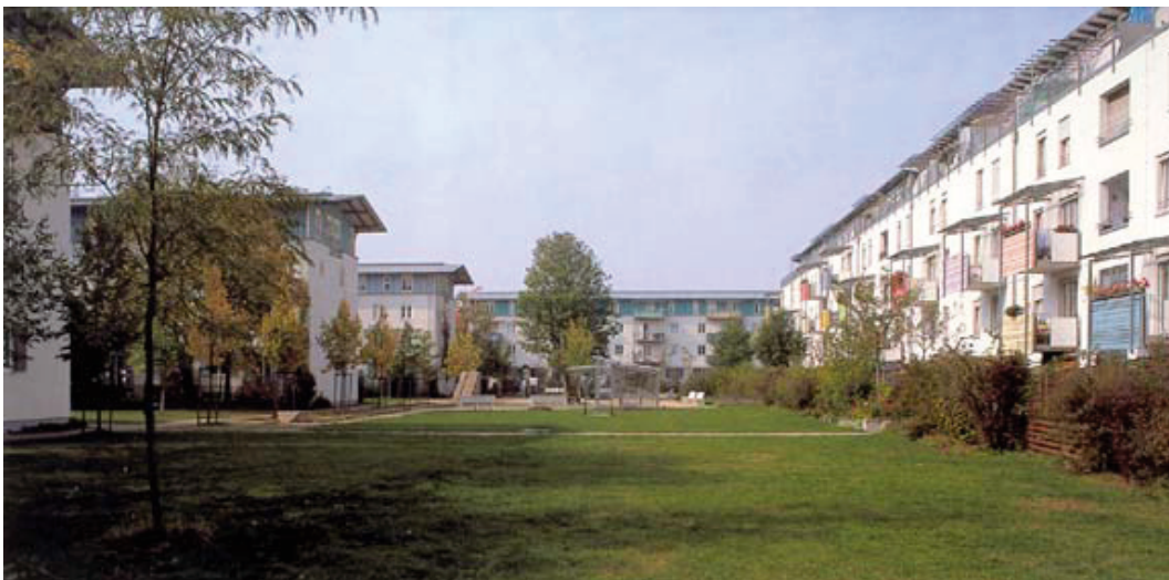
Abb. 3.3.9: Grüner Innenhofbereich. Rechts im Bild: Neubau mit 60 Wohnungen und Tiefgarage. Links im Bild: aufgestocktes Gebäude
