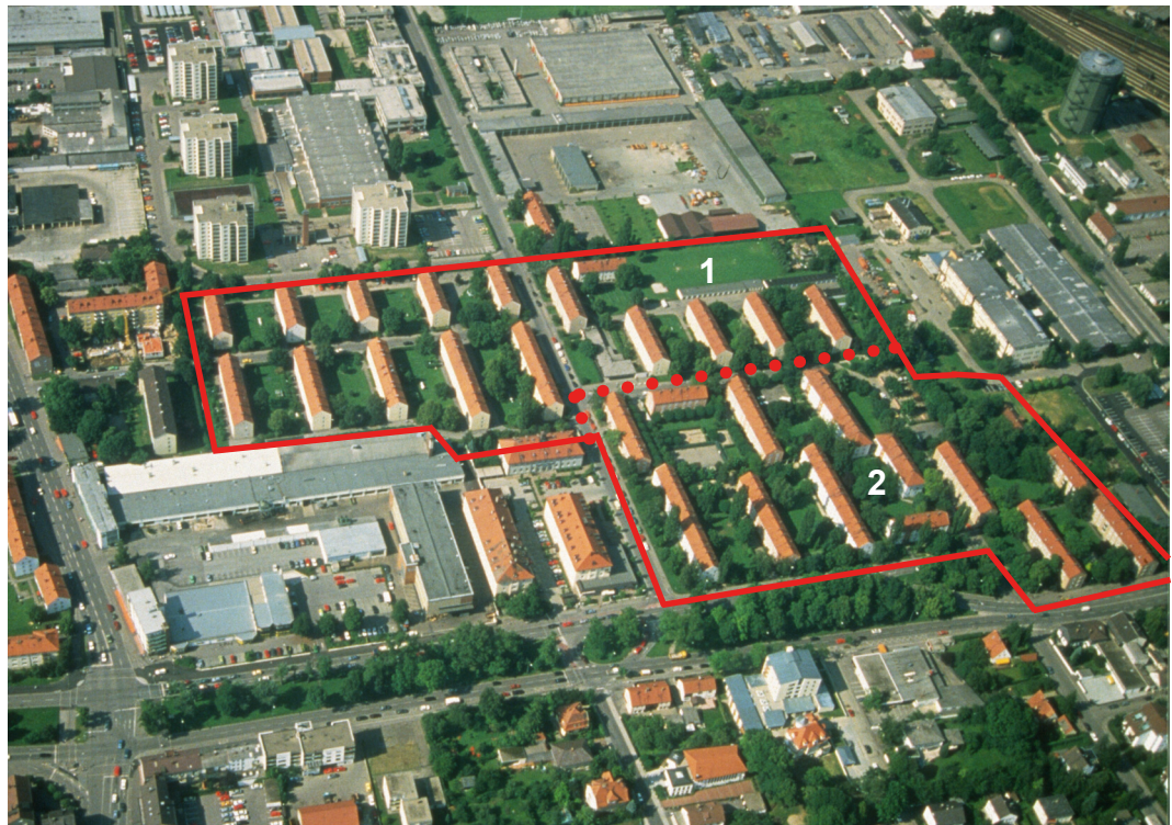
Abb. 3.3.6: Schrägbild Komponistenviertel vor Beginn der Baumaßnahmen ca. 1991
