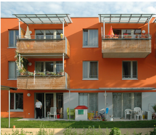
Abb. 3.3.67: Südseite Ergänzungsgebäude mit Terrassen und Balkonen
