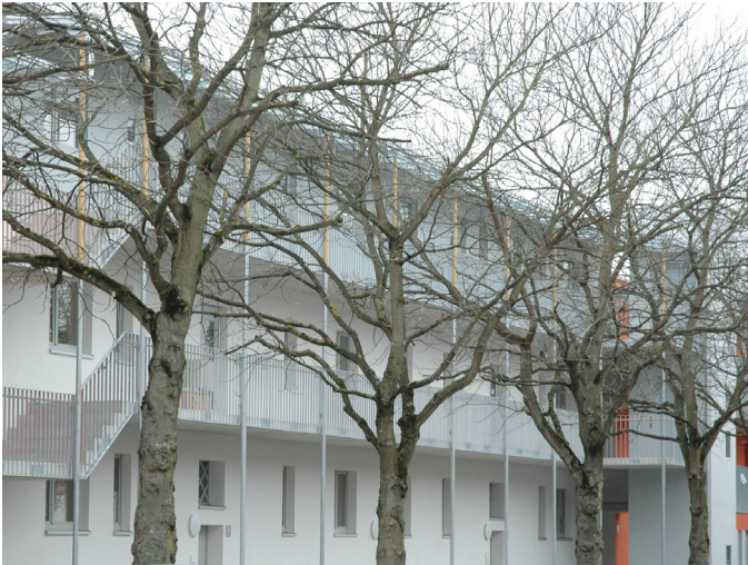
Abb. 3.3.65: Fassadenausschnitt modernisierter Altbestand, Birkenrieder Straße 2-4 von Norden
