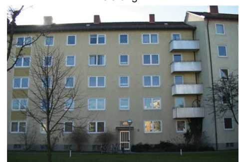
Abb. 3.3.79: Gebäude vor Aufstockung und Modernisierung
