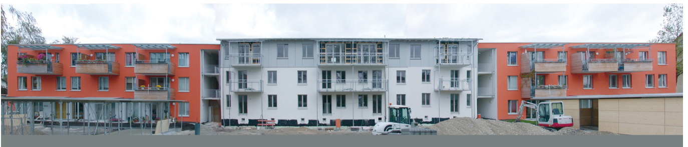
Abb. 3.3.69: Gesamtansicht des ersten Bauabschnitts von Süden, Birkenrieder Straße 2-4, kurz vor Fertigstellung im Herbst 2007
