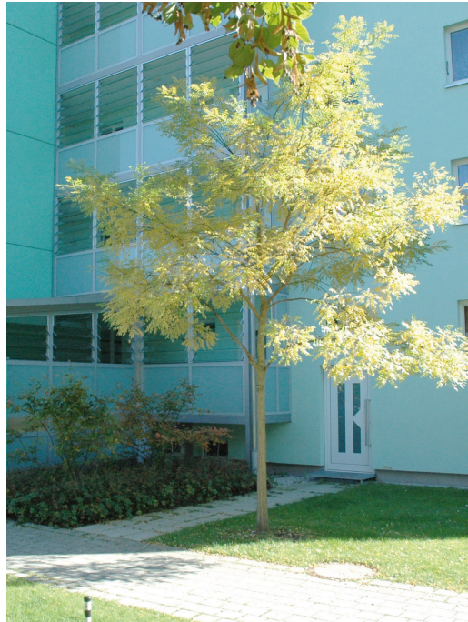
Abb. 3.3.82: Nordfassade mit den neuen Erschließungselementen Lift und Laubengang
