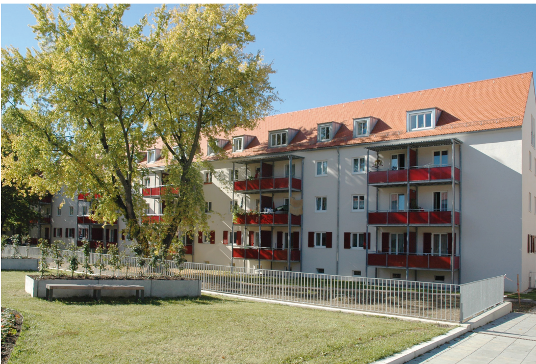
Abb. 3.3.33: Neugestaltung des östlichen Hofbereichs, modernisierter Altbau an der Kriemhildstraße mit gut nutzbaren Balkonen
