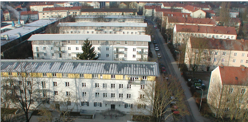
Abb. 3.3.3: Schrägluftbild mit Blick in die Brucknerstraße. Links im Bild: die bereits modernisierten und aufgestockten Gebäude, rechts die Gebäudezeilen noch im alten Zustand
