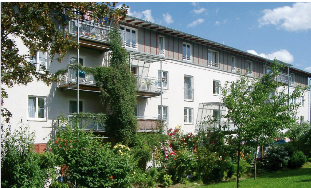
Abb. 3.3.8: Private Freireiche im Erdgeschoss, Balkone in den Obergeschosswohnungen
