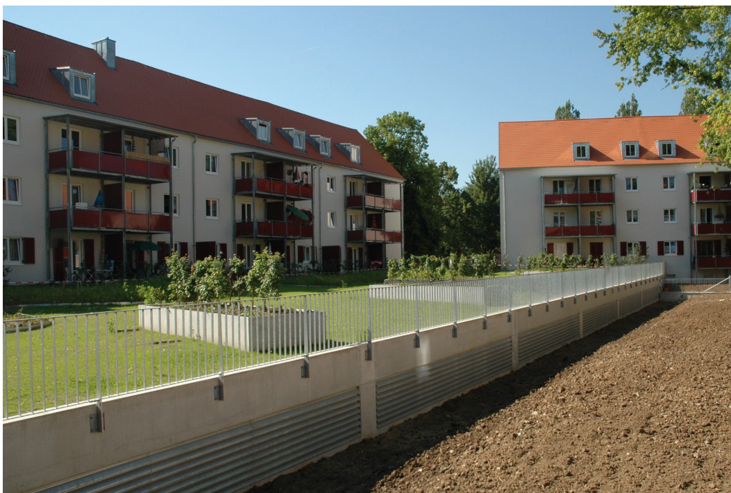
Abb. 4.5.65: Ansicht von der Hofseite mit Niveauanschluss Tiefgarage, Regensburg, Theodor-Storm-Straße 8–14
