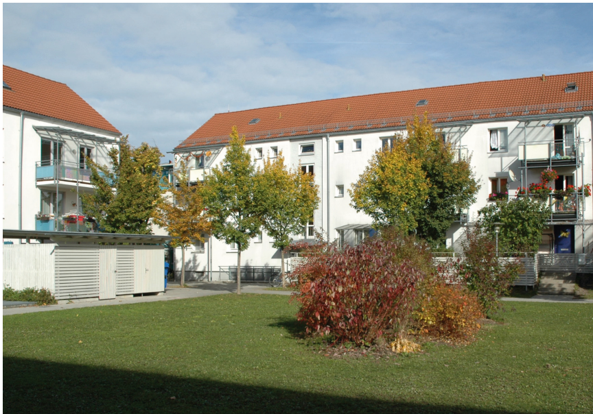
Abb. 4.1.65: Öffentlicher Grünbereich mit Schuppenvorzonen, zonierter Übergang zum Privatbereich, Waldkraiburg, Innenhof Graslitzer Straße
