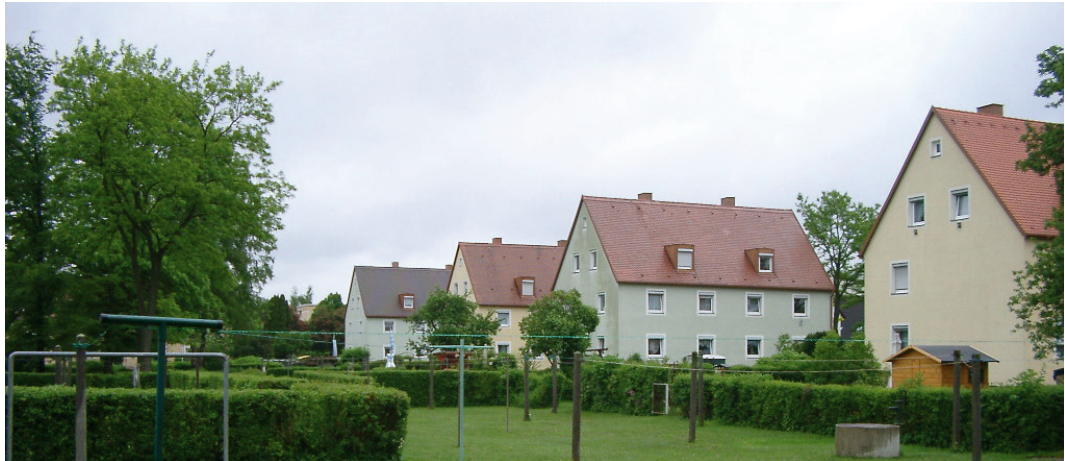
Abb. 3.3.64: Dachau, grüne Mitte mit Hecken zur Einfassung der Mietergärten
