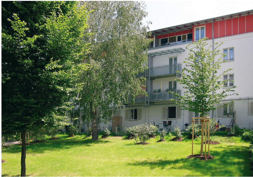
Abb. 4.1.64: Freiraumzonierung mit leichter Geländeanschüttung, Ingolstadt, Brucknerstraße 2–4
