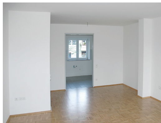
Abb. 4.5.95: Innenraum mit Durchbruch der Mitteltragwand, Verbindung Wohnen, Küche, Essplatz, Dachau, Birkenrieder Straße 2
