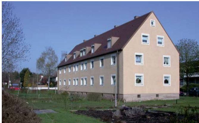
Abb. 5.3: Altbestand vor Beginn der Baumaßnahmen im Frühjahr 2005, Dachau, Birkenrieder Straße 2–4
