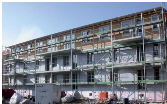
Abb. 5.4: Während der Modernisierungsmaßnahmen, aufgestockter Altbau Dachau, Birkenrieder Straße 2–4 Die Wärmedämmung im EG und 1. OG ist aufgebracht. Das 2. OG ist in Holzständerbauweise ausgeführt. Die bereits bezogenen Neubauten links und rechts sind auf der Abbildung nicht zu erkennen, Juni/2007
