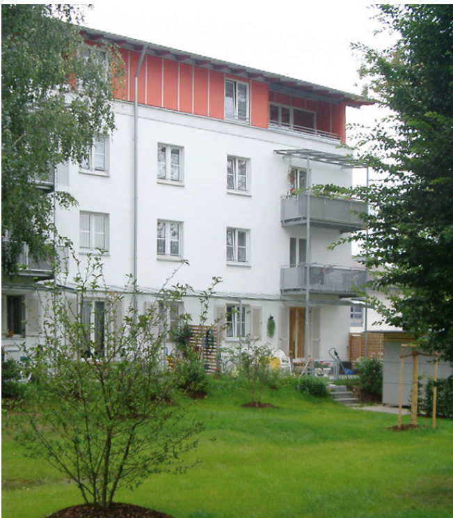
Abb. 4.6.1: Gartenseite eines aufgestockten Gebäudes in Ingolstadt an der Brucknerstraße
