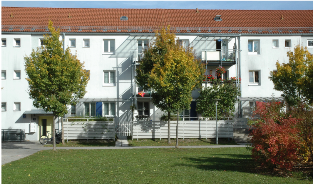
Abb. 3.3.21: Gartenseite eines modernisierten Gebäudes mit Anhebung des Erdgeschossbereichs
