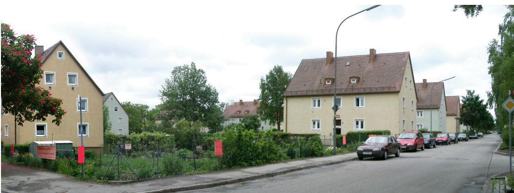
Abb. 3.3.63: Siedlungsquartier Dachau von Nordwesten, im Vordergrund Mietergärten, 2002
