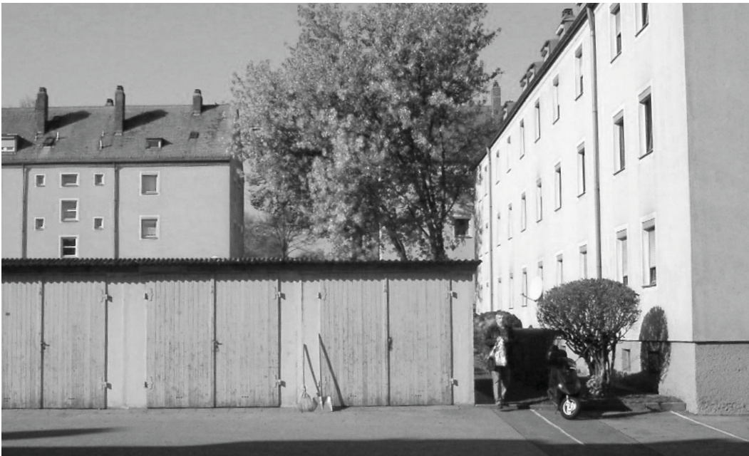
Abb. 4.1.26: Hausnah angeordnete Garagenanlage mit versiegelter Fläche, Regensburg Kriemhildstraße
