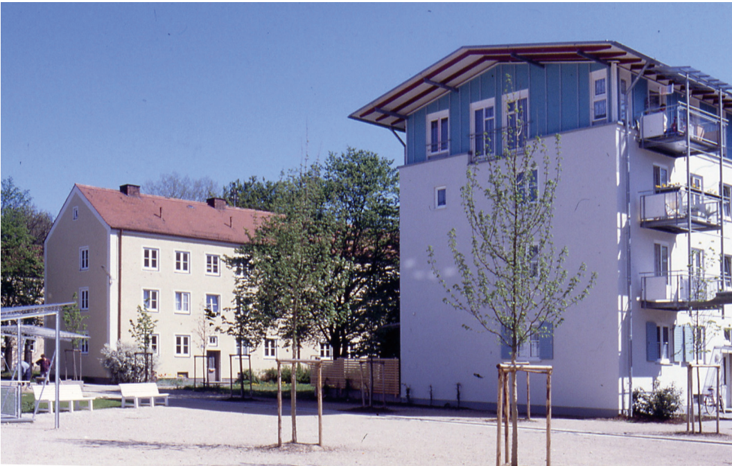
Abb. 3.3.7: Links im Hintergrund: Altbestand; rechts: aufgestocktes Gebäude, im Vordergrund Gemeinschaftsfläche
