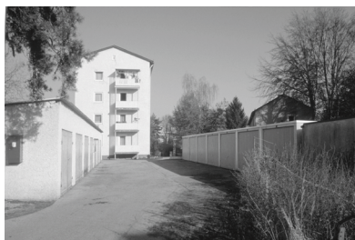
Abb. 4.4.2: Garagenhof mit versiegelter Zufahrt, Waldkraiburg, Altbestand 1986
