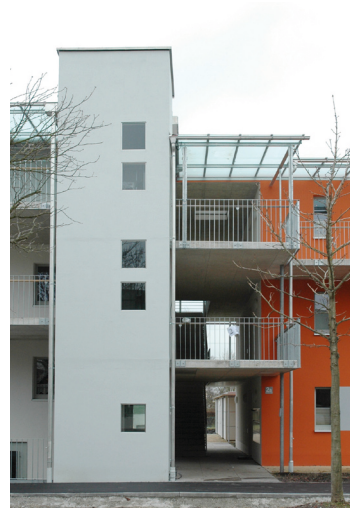
Abb. 3.3.66: Liftanbau als Bindeglied zwischen Altbestand und Ergänzungsgebäude
