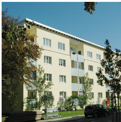
Abb. 3.3.84: Südfassade der Gebäude an der Hinterbärenbadstraße mit vorgestellten neuen Balkonanlagen
