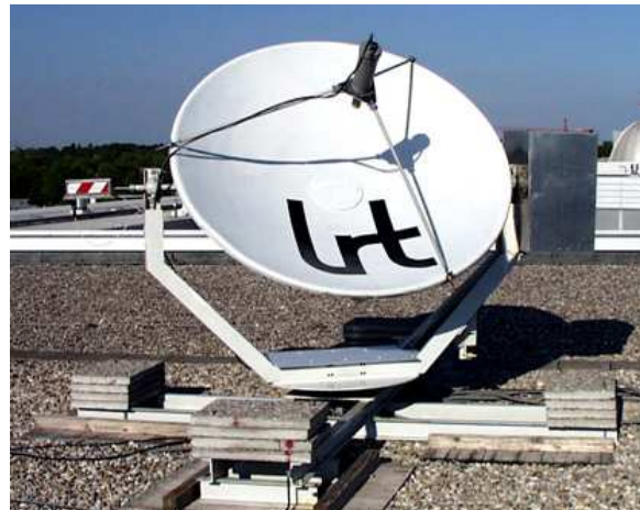
Abb. 3-10: Antennendrehstand nach den Umbauarbeiten am Gebäudedach
