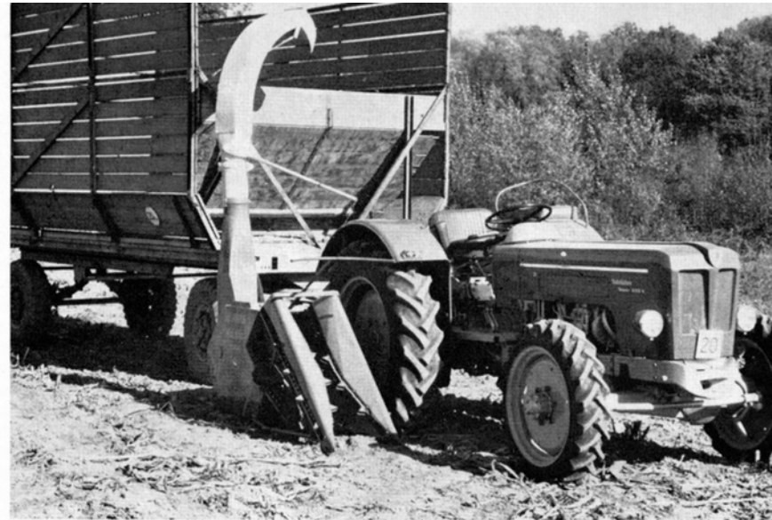
Bild 5: Mais-Anbau-Trommel-Feldhäcksler (Mengele, Eberhard) — in Straßenfahrbreite.
