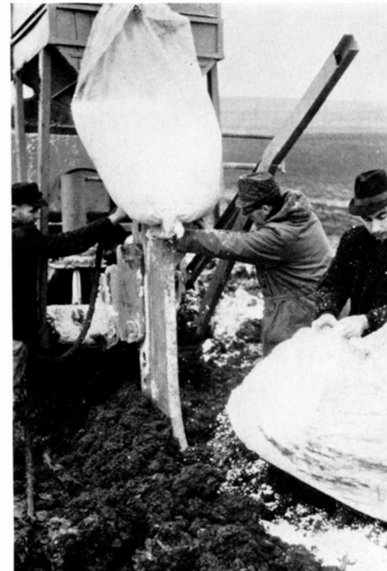
Abb. 8 Untergrundlockerer in Kombination mit Styromulleinbringung.
