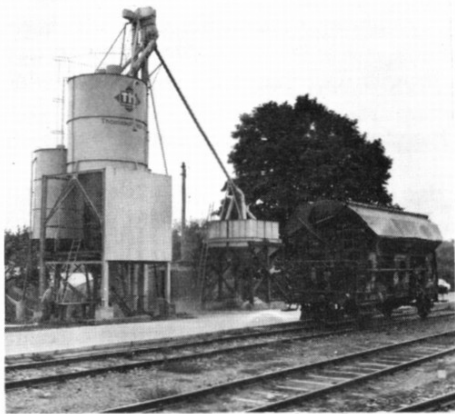
Abb. 1: Anlage mit Stahlhochsilos als Umschlagstation für mehlförmigen Dünger. Zur Beschickung und Entnahme werden meist Elevatoren eingesetzt.
