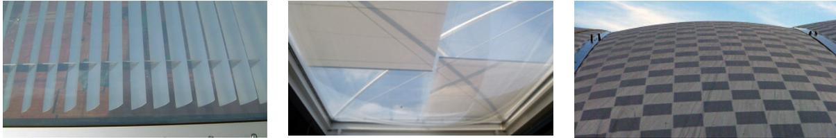
Abb. 7-6 Integrierter Sonnenschutz bei ETFE-Folienkissen: (a) Sonnenschutzlamellen, (b) textile Membran und (c) gegensätzliche Bedruckung einzelner Folienlagen
