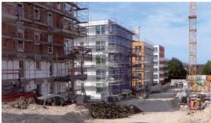
Fotos aus der Bauphase Fotos: Architekturbüro 2, Regensburg Quelle: Dokumentation, Thurn und Taxis (Hg.) 2007
