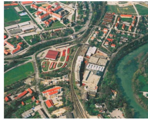
Landsberg am Lech, Pflugfabrik. Schrägluftbild, Mai 1992
