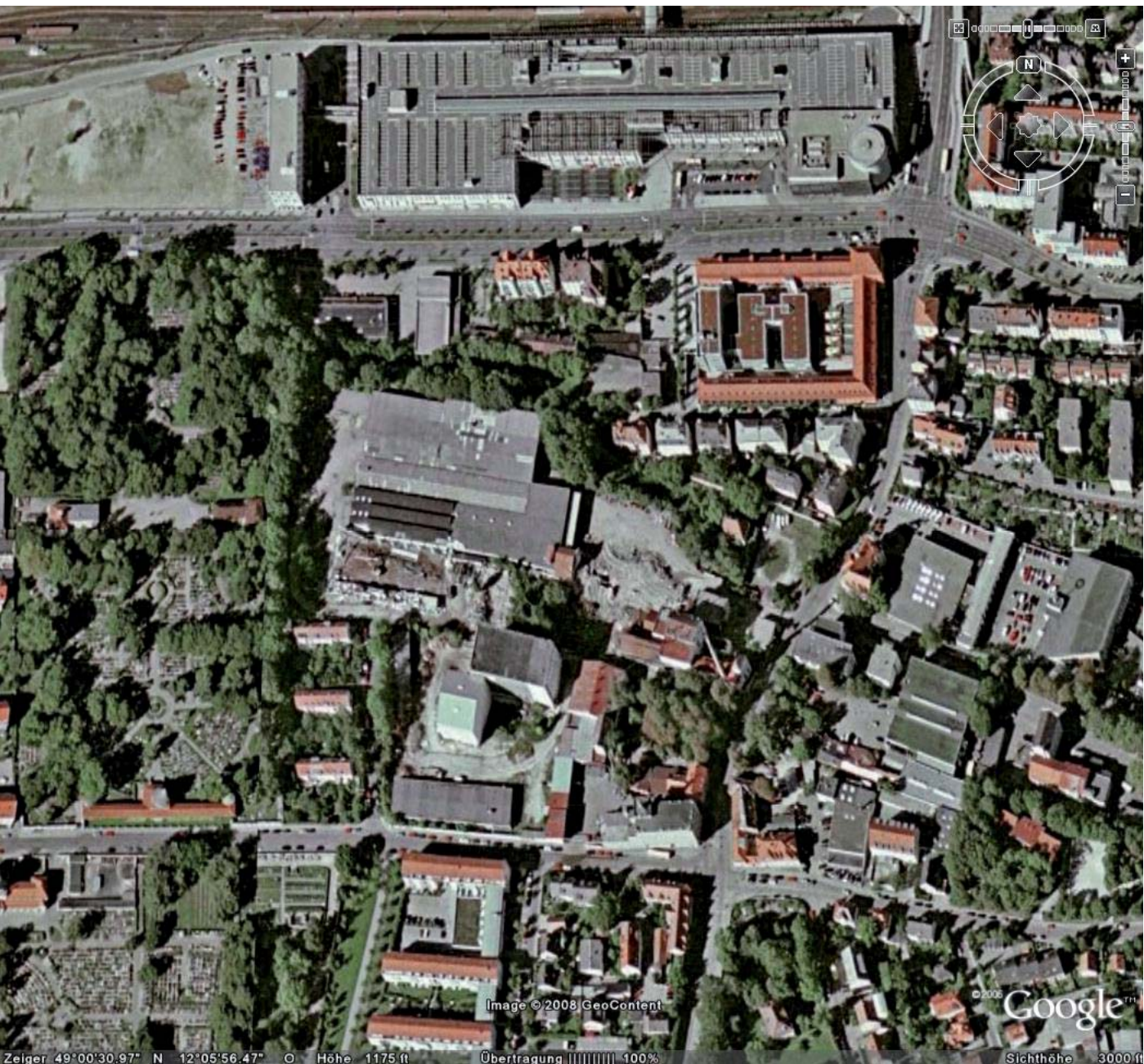
Regensburg, Brauereiareal Thurn und Taxis Luftbild Juli 2004 Quelle: Google Earth
