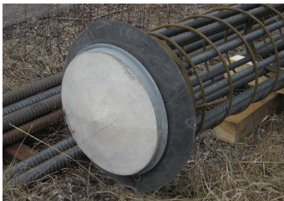
Abbildung C.11: Pfahlfußdose an Bewehrungskorb montiert (Unterseite)
