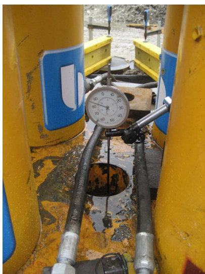
Abbildung C.51: Messen der Anlege- setzung des Stahlblechs am Kopf des Druckpfahls
