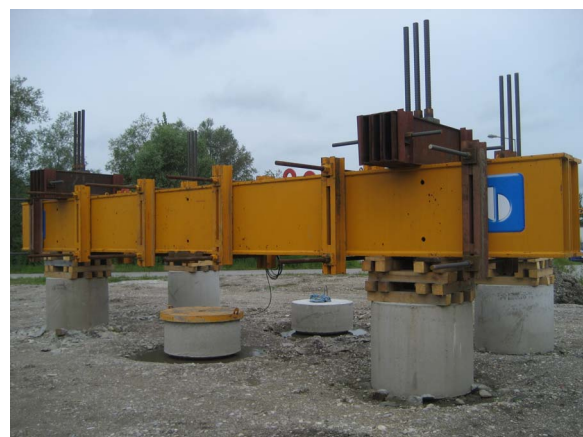
Abbildung C.48: Belastungstraverse für Pfahlprobelastungen
