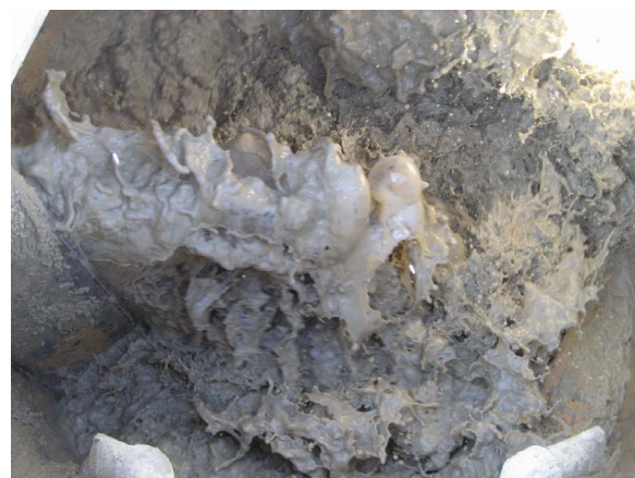
Abbildung C.44: Bentonitsuspension in der Mischanlage
