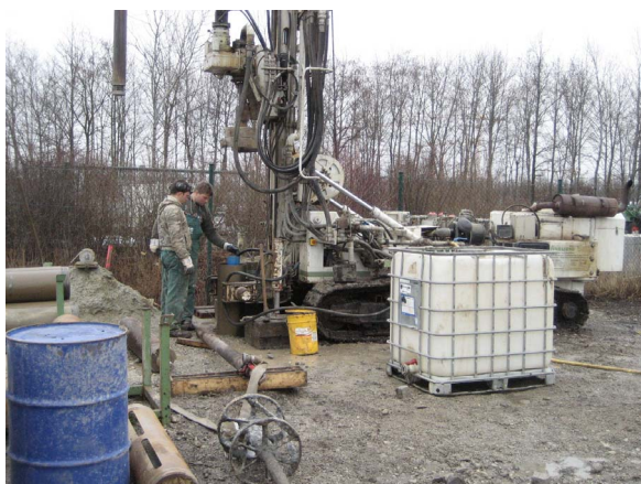
Abbildung C.1: Baugrunderkundung (GWM)
