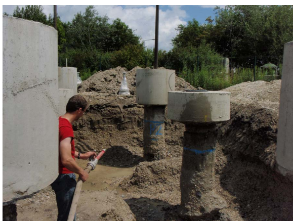
Abbildung C.59: Abspritzen der Pfähle
