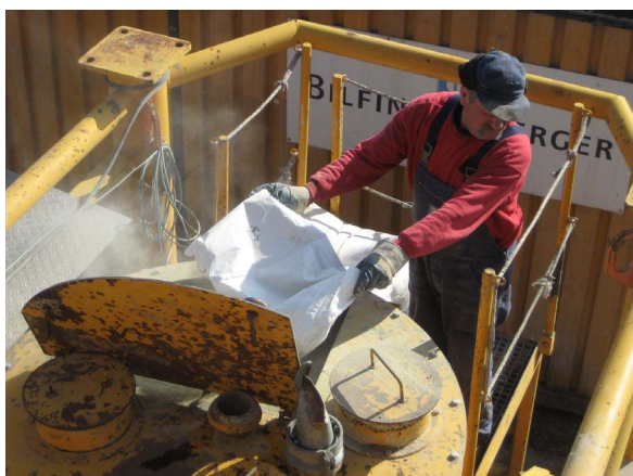
Abbildung C.43: Zugabe von Hand des Bentonits zur Mischanlage
