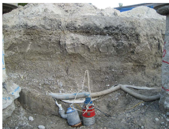
Abbildung C.60: Baugrundprofil bis ca. 2 m unter GOK
