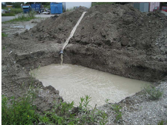
Abbildung C.55: Versickerungsbecken für Wasserhaltung
