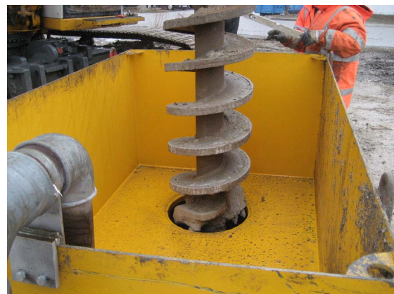
Abbildung C.18: Bohrschnecke beim Einfahren ins Bohrloch
