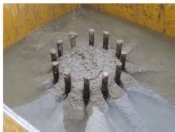
Abbildung C.36: Pfahlkopf nach Ende des Betonierens
