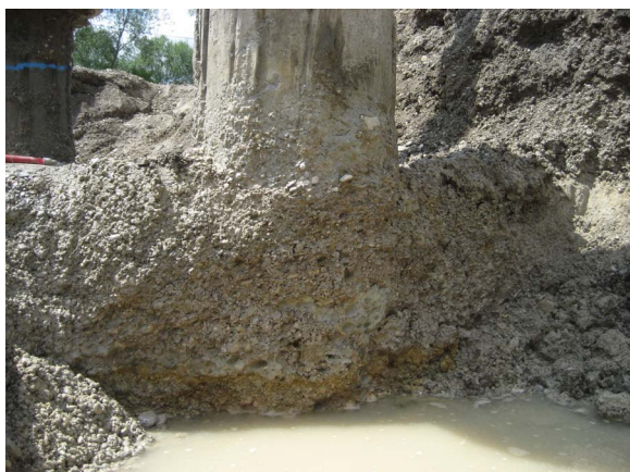
Abbildung C.57: Freilegen von Pfahl P 3 (unter Bentonitstützung hergestellt)
