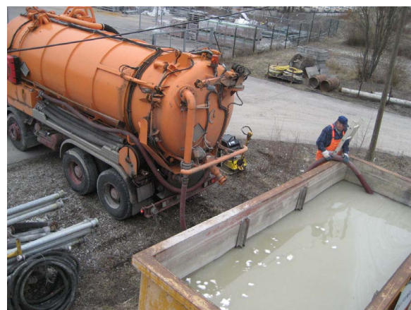
Abbildung C.42: Abholung von Restflüssigkeit durch Saugwagen (Entsorgung in Kläranlage)
