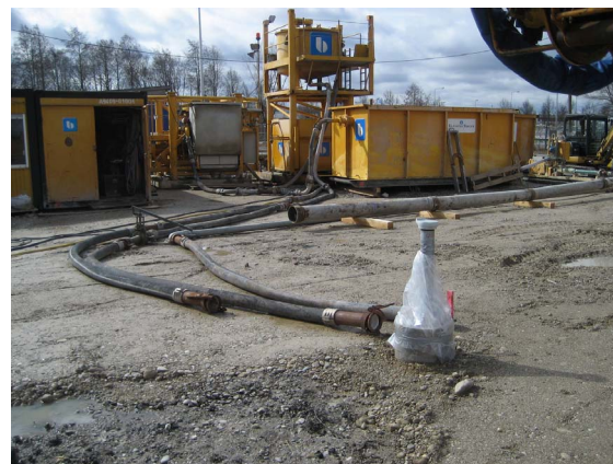
Abbildung C.6: Zulauf (mit Schieber) und Ablauf für Stützflüssigkeit
