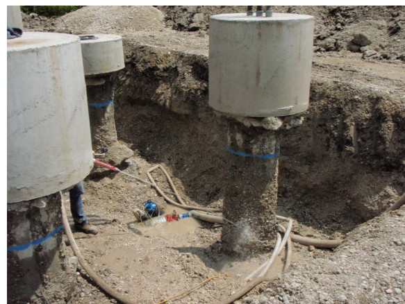
Abbildung C.54: Wasserhaltung und freigelegte Pfähle
