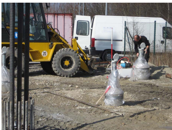
Abbildung C.41: Grundwasserbeprobung während der Bauphase
