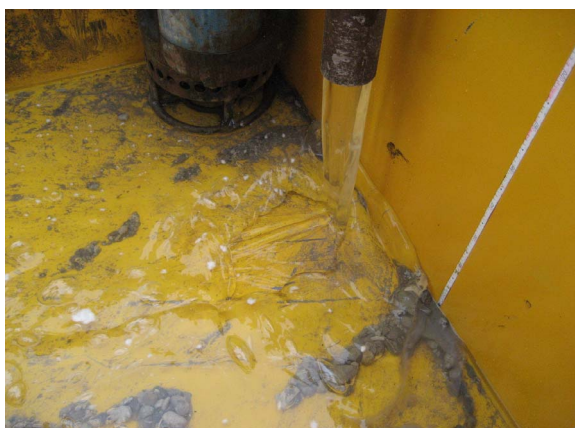
Abbildung C.19: Einleiten der Stützflüssigkeit (einzelne Polymerflocken erkennbar)
