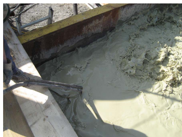
Abbildung C.46: Durchmischen der Bentonitsuspension mit Druckluft
