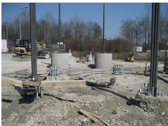
Abbildung C.47: Pfahlkopfweiterungen durch ausbetonierte Schachtringe
