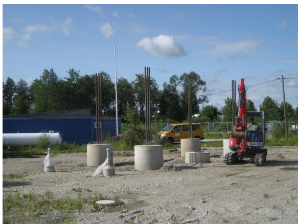
Abbildung C.53: Freilegen der Pfähle mit Mini- bagger
