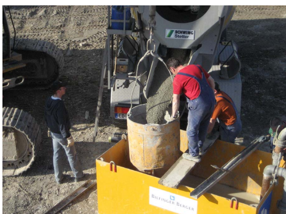
Abbildung C.35: Betonieren im Kontraktorverfahren
