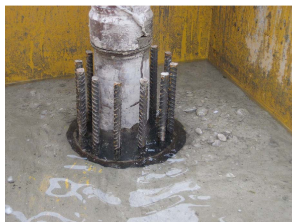
Abbildung C.34: Einführen des Betonierrohrs
