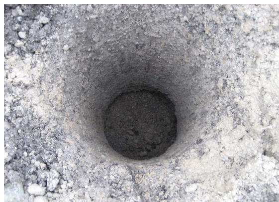
Abbildung 16: Vorbohrung (leichter Nachfall im Sohlbereich erkennbar)
