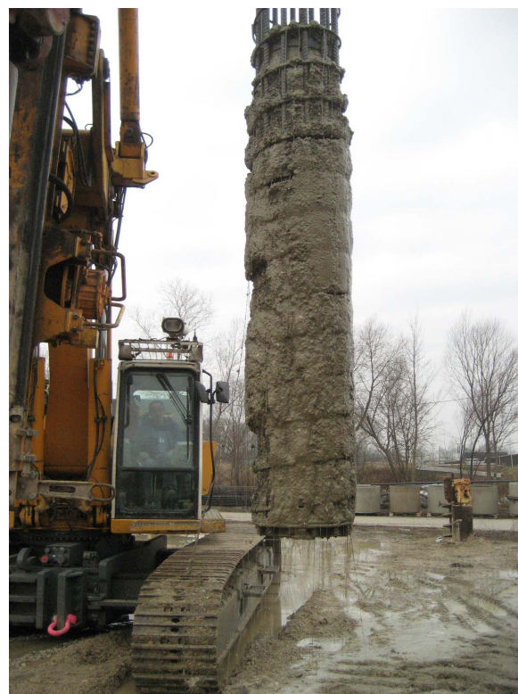
Abbildung C.38: Bewehrungskorb mit vorzeitig angesteiftem Beton (Pfahl P 1)
