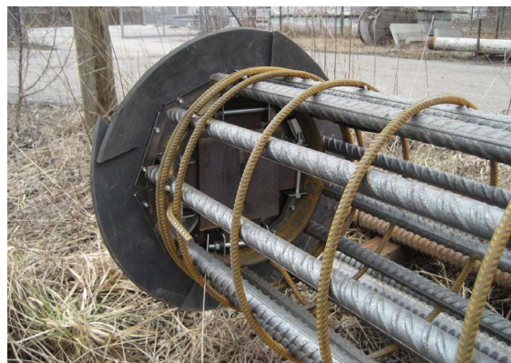
Abbildung C.12: Pfahlfußdose an Bewehrungskorb montiert (Oberseite)
