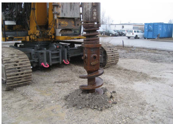
Abbildung 15: Vorbohren für Ansatzverrohrung
