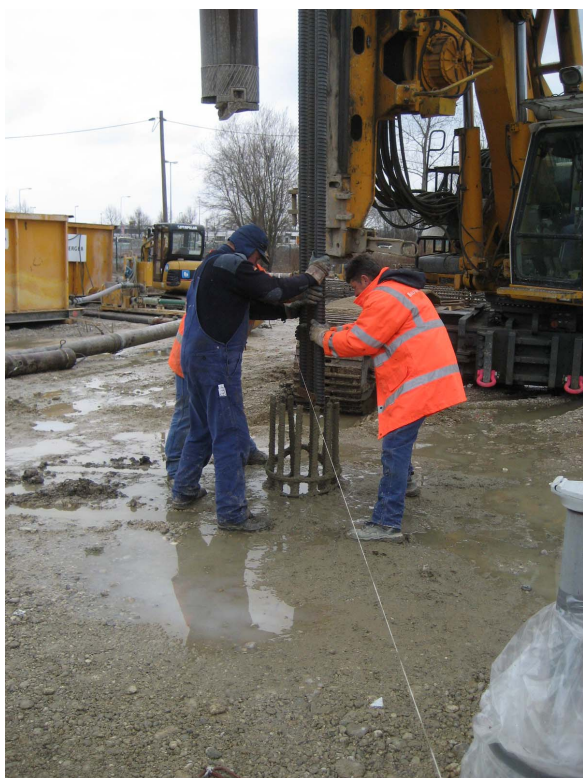
Abbildung C.37: Einsetzen von GEWI-Stäben nach dem Betonieren eines Zugpfahls
