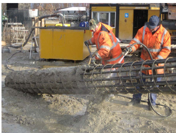
Abbildung C.39: Reinigen des geborgenen Bewehrungskorbs (Pfahl P 1)
