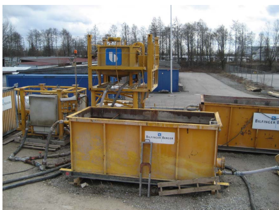
Abbildung C.9: Container für Bentonitsuspension (vorne) und Restpolymerlösungen (hinten rechts)
