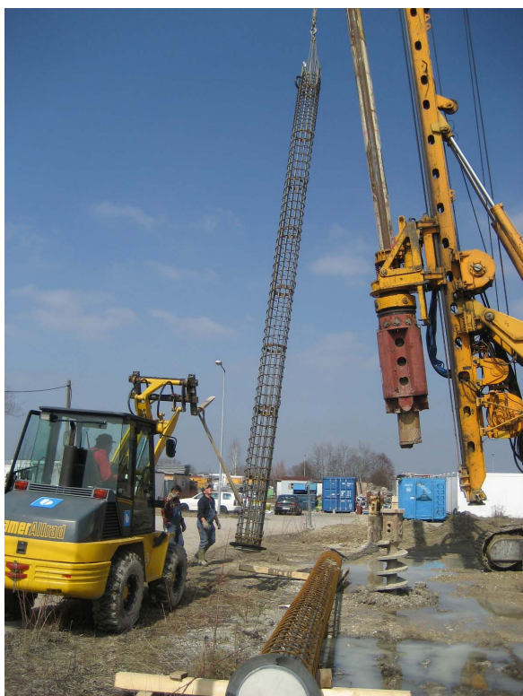
Abbildung C.33: Bewehrungskorb für Druckpfahl
