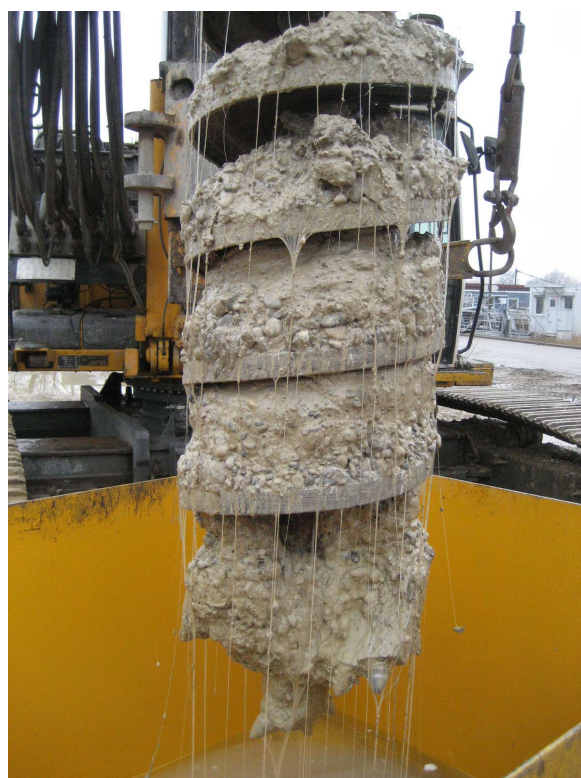
Abbildung C.26: gefüllte Bohrschnecke
