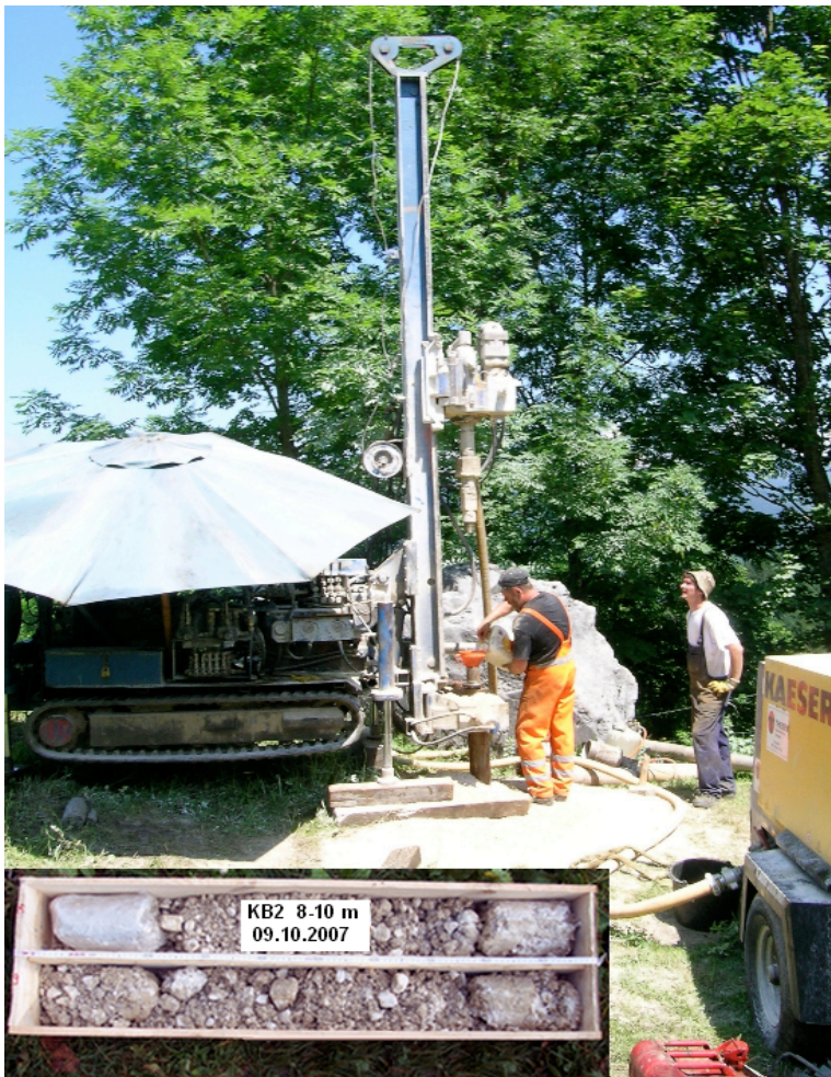
Abb. 20: Bohrmannschaft beim Abteufen einer Bohrung an der Aggenalm Hangbewegung.
